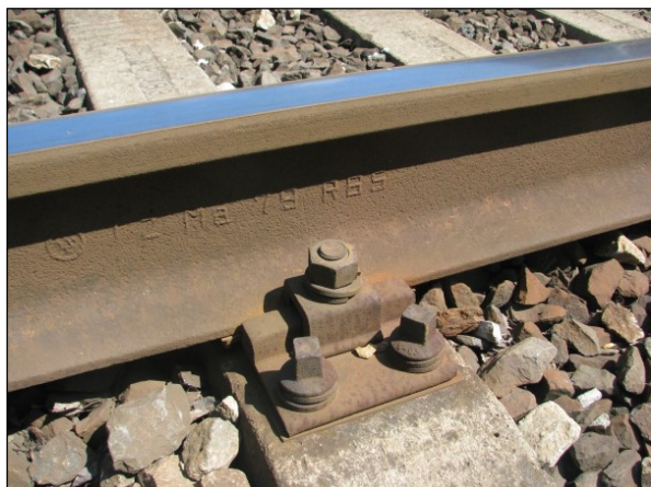
Detail železničního svršku, upevnění K
