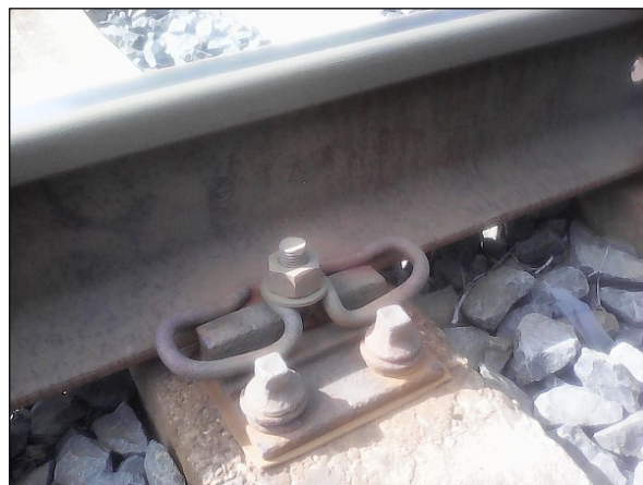
Detail železničního svršku, upevnění Ks
